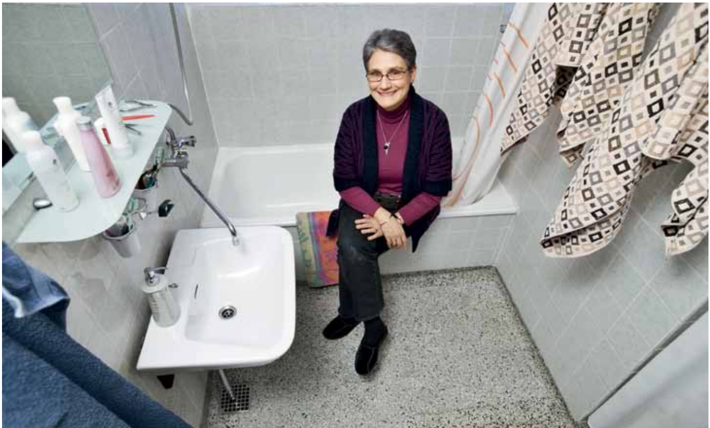
"Der var sat et kryds der, hvor de mente bruddet var. Gulvet blev brudt op, og vandet stod i en stråle ud af hullet", forklarer Ella Stokbro.
