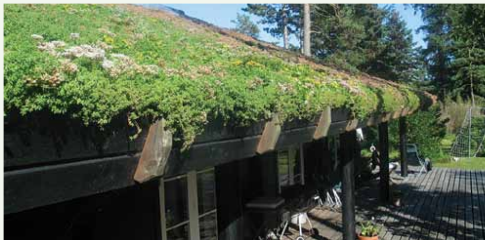
Grønne tage er flotte. Og det er vigtigt, at man vurderer, om tagkonstruktionen kan bære vægten.
