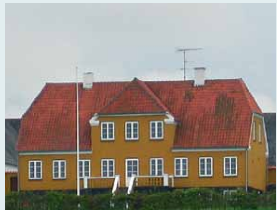
Skorstenen har betydning for husets arkitektur. (Spørgerens foto)
