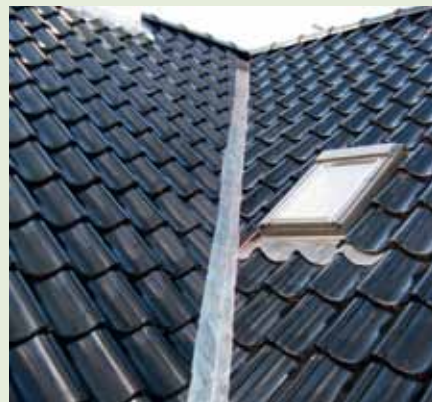
Skotrender, belagt med zink, tæres af syre i luften og bliver utætte.
