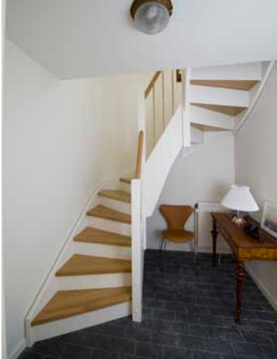
Den gamle spindeltrappe til første sal er udskiftet til en større halvsvingstrappe, så der er bedre adgangsforskel mellem køkken og dagligstue ovenpå.
