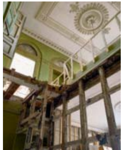
Under restaureringen var der frit udsyn mellem etagerne.
