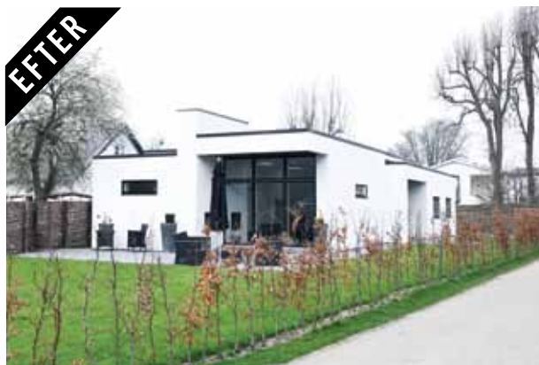
Efter: Det er svært at se, at dette hus oprindeligt var et parcelhus. De store vinduespartier giver det lysindfald, som familien ønskede sig.
