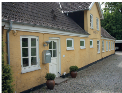
Huset i Brovst stod siden 1980'erne med en gul, oliebaseeret facademaling i den en overgang meget moderigtige, skagensgule kulør.
