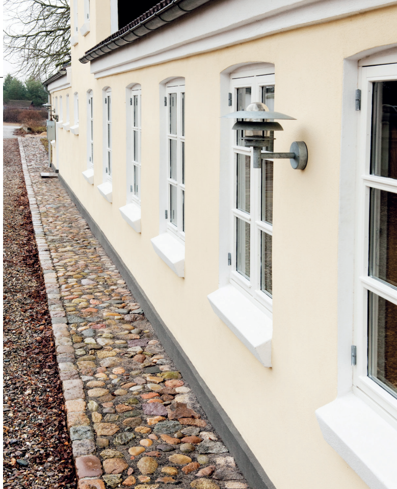
Sporene efter de kraftige sætninger på gavlen er helt væk efter pudningen. Bemærk den flotte detalje med pigsten langs fundamentet.
