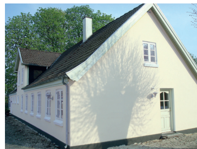
Sporene efter de kraftige sætninger på gavlen er helt væk efter pudningen. Bemærk den flotte detalje med pigsten langs fundamentet.
