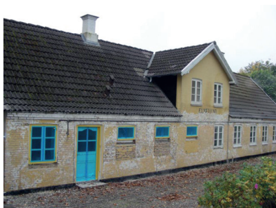
De gamle facadelag af mørtel, kalk og oliemaling blev fjernet helt ind til murstenene med en højtrykspulver, der ikke beskadigede den gamle fuger.
