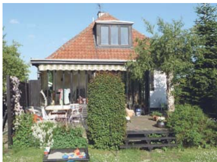
Huset før ombygningen. Den gamle havestue virkede som en barriere og betød, at familien Larsen ikke brugte deres have så meget.
