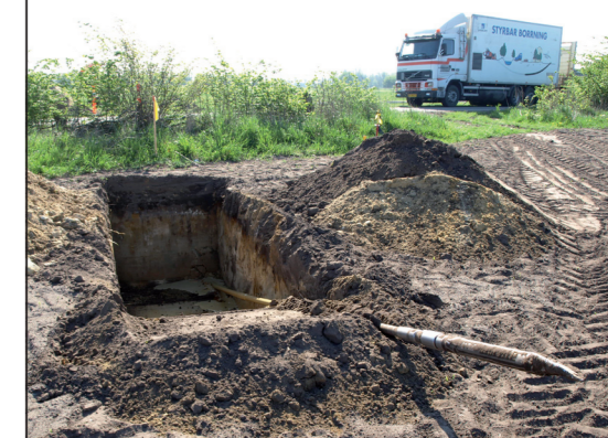
Underboring ved vej
