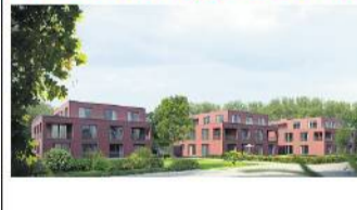
V. 181 kWh/(m 2 a), Gas, Bj. 1989, Energie-Kl. F
