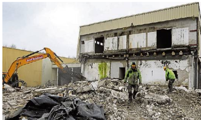
An der Alten Heerstraße im GMHütter Stadtteil Harderberg ist diese Woche mit dem Abriss der Gebäude der ehemaligen Fleischzentrale begonnen worden. Bis 2020 entstehen hier Stadtvielen für Senioren-Wohnen. Foto: Gert Westdörp
