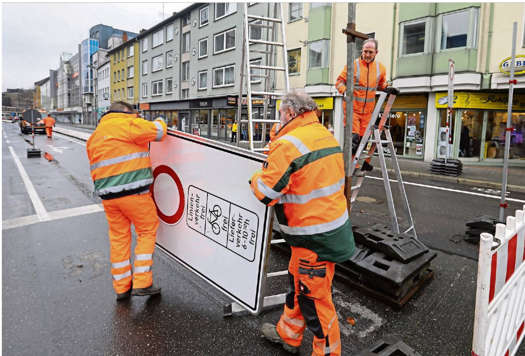
Freitag, 10 Uhr: Die Sperrschilde werden abgebaut. Der Neumarkt in Osnabrück ist für den Autoverkehr wieder geöffnet.
