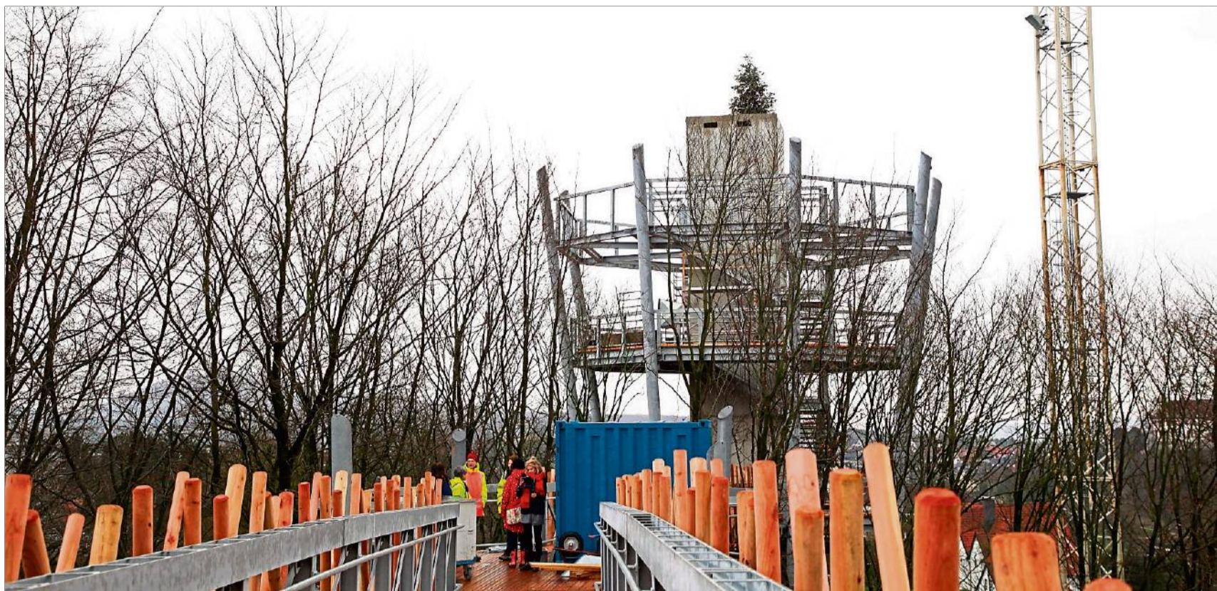
Ortstermin in luftiger Höhe: Noch sind es gut 70 Tage bis zur Eröffnung der Laga. Und es gibt noch viel zu tun. Auch am Baumwipfelpfad. Foto: Felix Dittmar
