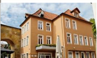
V. 183 kWh/(m 2 a), Gas, Bj. 1932, Energie-Kl. F
